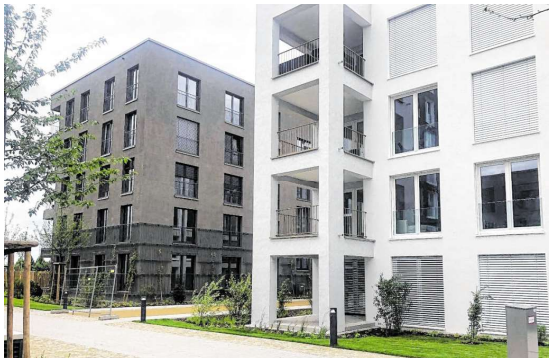
Diese Gebäude im Neubaugebiet „Schwetzingener Höfe“ auf dem ehemaligen Pfaudler-Gelände an der Scheffelstraße sind unter anderem bereits fertiggestellt.
