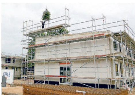
Nun wurde Richtfest für die Reihenhäuser in der Erich-Veith-Straße gefeiert. Foto: Popanda
